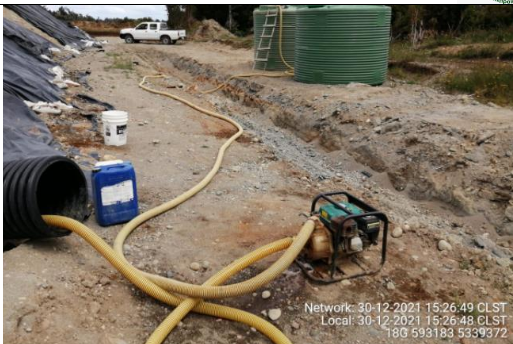
Fotografía N°7: Retiro de Lixiviados desde diagonal por Personal Municipal. Tomada: Jueves 30 de Diciembre del 2021.
