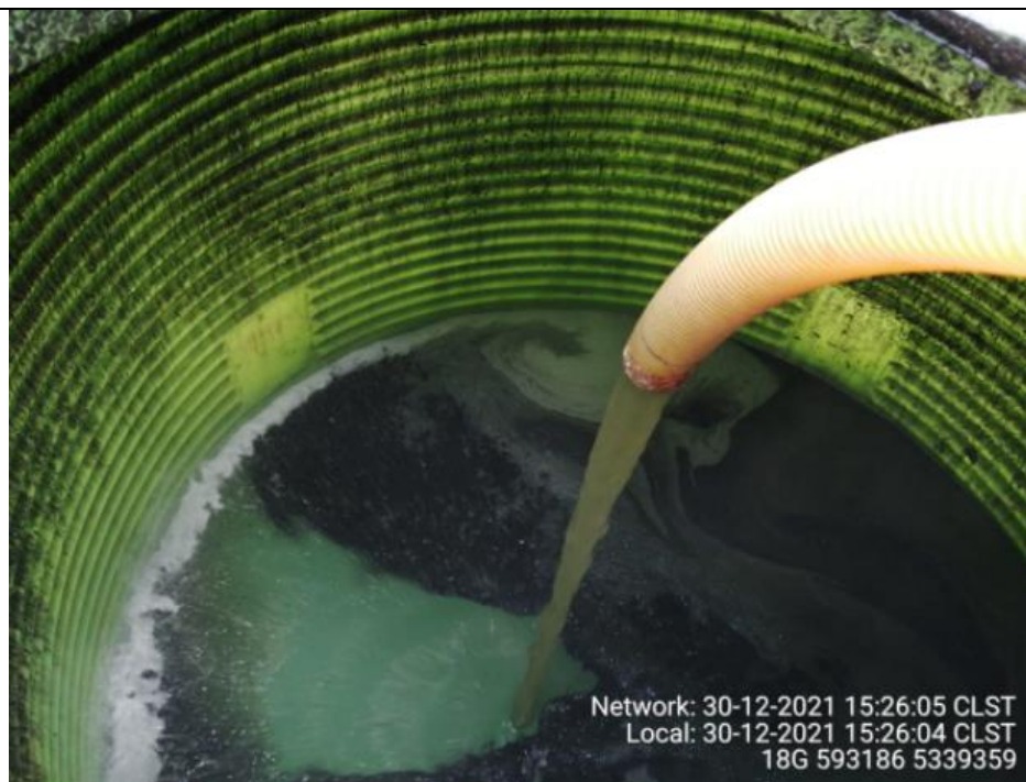
Fotografía N°8: Retiro de Lixiviados a estanque por personal municipal. Tomada: Jueves 30 de Diciembre del 2021.
