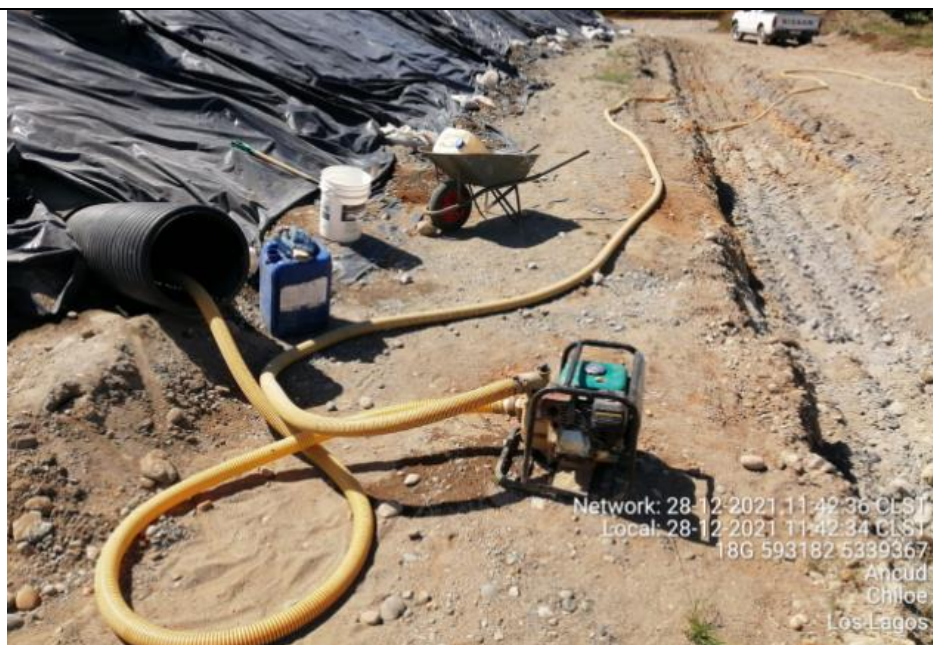
Fotografía N°3: Retiro de Lixiviados desde D02 por personal municipal. Tomada: Martes 28 de Diciembre del 2021.
