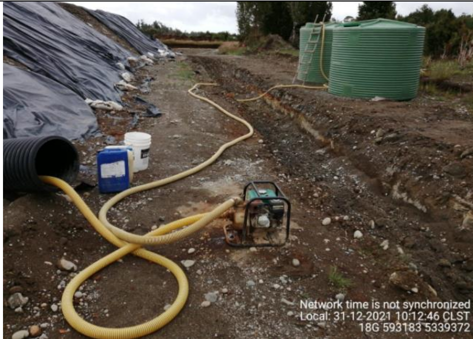
Fotografía N°9: Extracción de Lixiviados desde diagonal D03 por personal municipal. Tomada: Viernes 31 de Diciembre del 2021.
