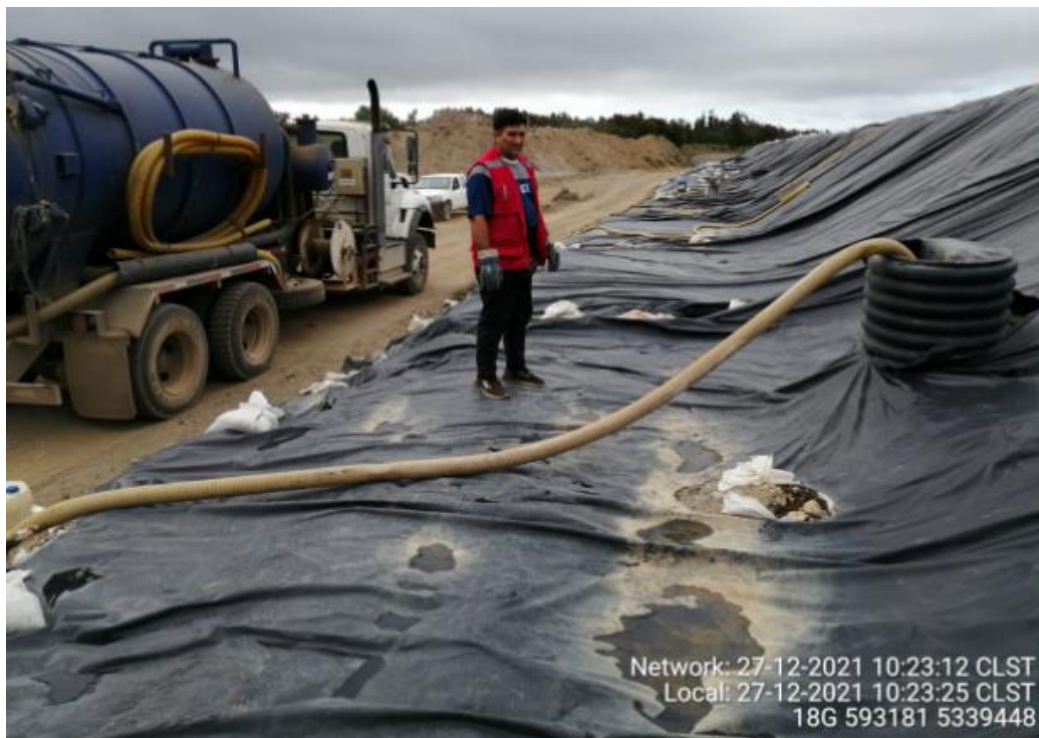
Fotografía N°2: Retiro de Lixiviados desde camaras. Tomada: Lunes 27 de Diciembre del 2021.
