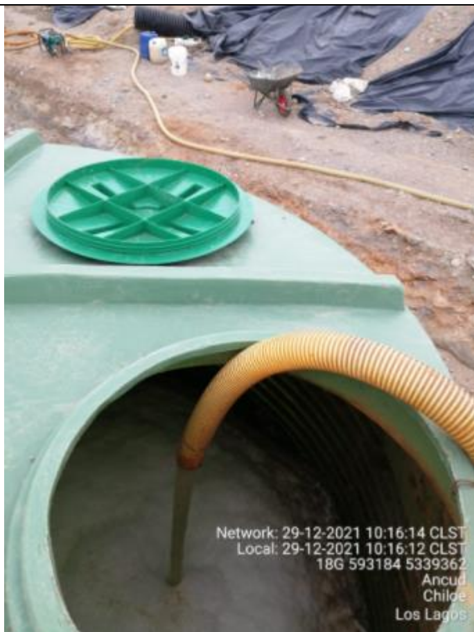
Fotografía N°6: Retiro de Lixiviados a estanque de acumulación. Tomada: Miércoles 29 de Diciembre del 2021.
