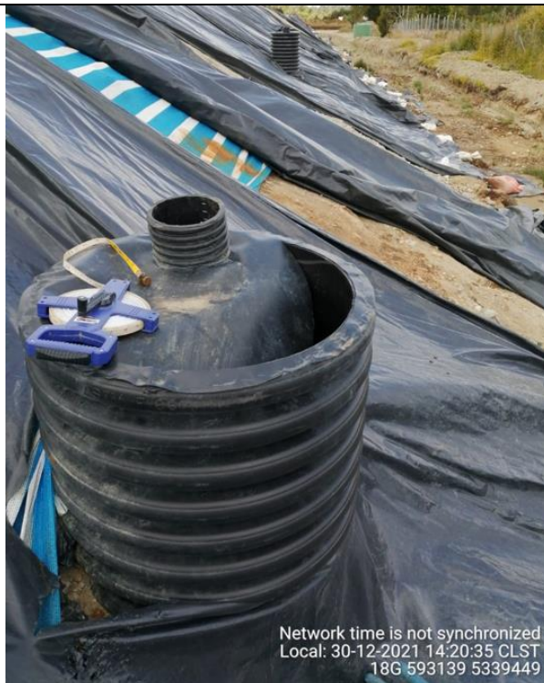
Fotografía N°14: Medición de Niveles de cámaras por Personal Municipal. Tomada: 30 de Diciembre del 2021.
