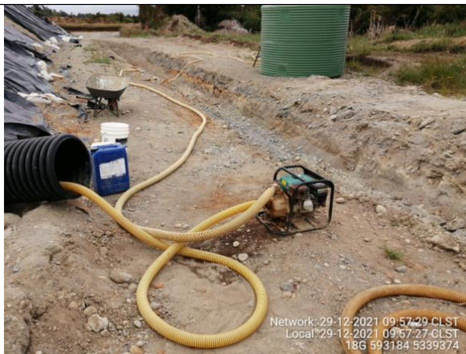
Fotografía N°5: Retiro de Lixiviados desde diagonal. Tomada: Miércoles 29 de Diciembre del 2021.
